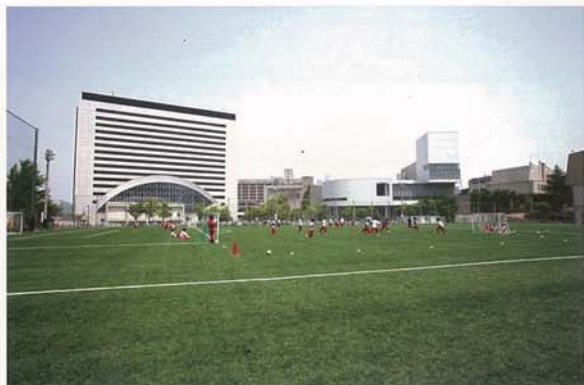
■工法採用事例 福岡大学仮設サッカー場
