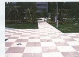
NTT 病院関東外構工事
